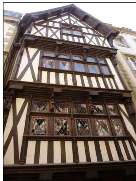
La maison à pondalez à Morlaix
