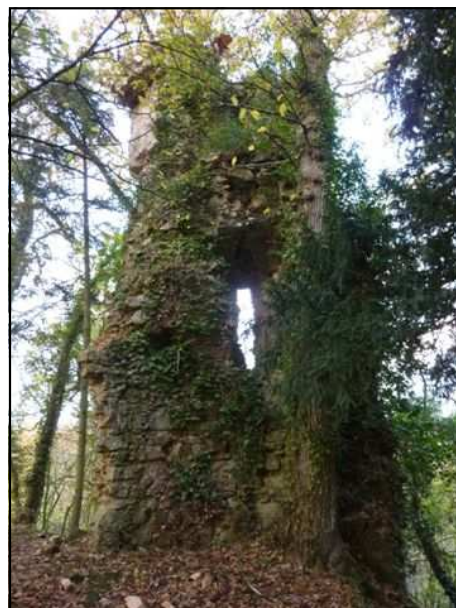
Le reste du donjon au sommet de la motte de Chevré
