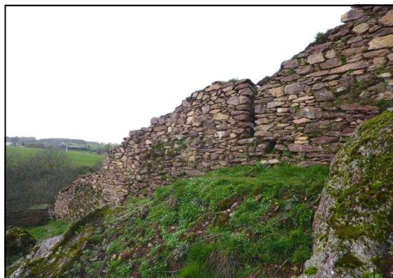
Le mur sud du château de Boutavent en grande partie restauré
