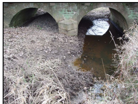
Le pont sur la route de la chapelle St-Aubert
