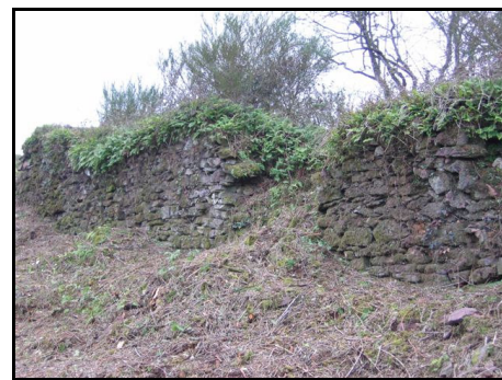
Mur en pierres sèches fermant la cour du château
